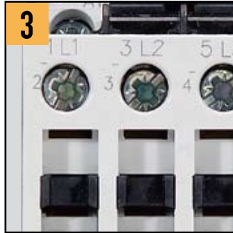
3 Bağlantı noktalarının açık işaretlemesi sayesinde kolay kablolama
